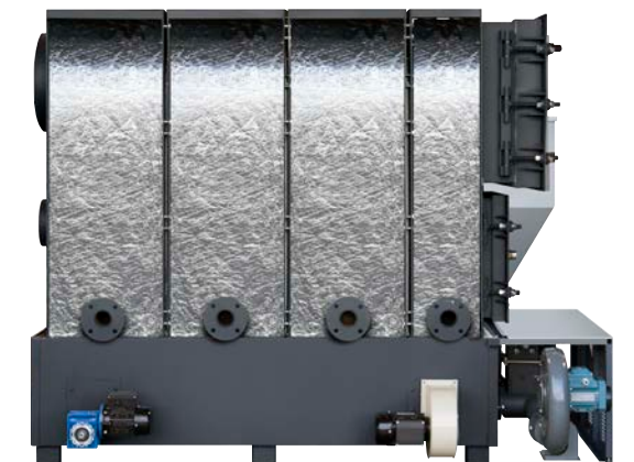
6 - Montaje aislamiento y envolventes
