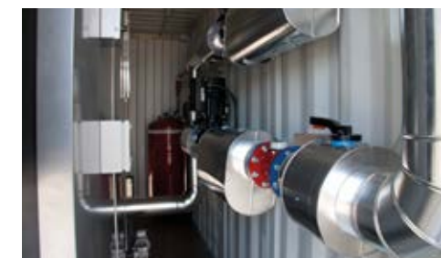
Contenedor con caldera de 500 kW y esquema hidráulico sólo calefacción
